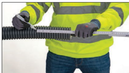
1 Odkreślić linię w odległości (x, y, z) + 1 cm od końca rury.
