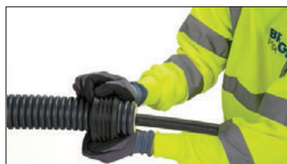
6 Nałożyć gumowy pierścień uszczelniający.
