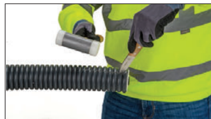
3 Rozciąć płaszcz. Uwaga: nie uszkodzić rury!
