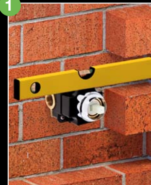
Wypoziomowanie elementu podtynkowego.
