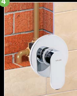
Montaż elementów zewnętrznych.
