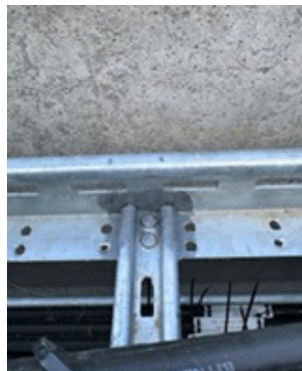
3. Nałożenie pasty cynkowej odpowiedniej grubości
