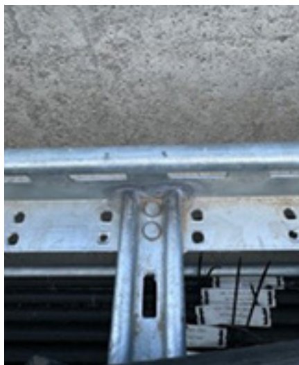
2. Mechaniczne usunięcie luźnego nalotu szczotka miedzianą
